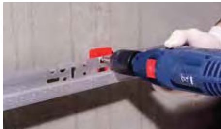
Монтаж посадочного профиля Kale при помощи дюбеля.
