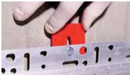
Выравнивание посадочного профиля Kale при помощи пластиковых колодок.
