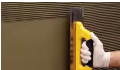
Нанесение на основание первого слоя штукатурного раствора.
