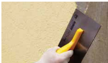
Декоративные покрытия, наносятся на поверхность при помощи мастерка. Толщина меняется от типа штукатурки.
