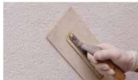
До высыхания покрытия, поверхность сглаживается пластиковым мастерком с образованием текстуры. Так как Minart является минеральным материалом, то после высыхания его обязательно нужно обработать грунтовкой Kale Silastar или покрасить вододисперсионной фасадной краской Kale.
