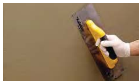
Нанесение на основание второго слоя штукатурного раствора.
