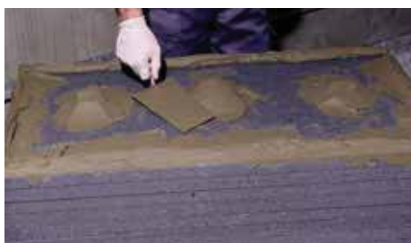
Клеевой раствор для теплоизоляционной плитки, необходимо нанести полоской по всем краям плитки и достаточным количеством точек по центру плитки. Клей должен охватывать минимум 40% задней части плитки.
