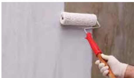
Нанесение на основание грунтовки Silastar.
