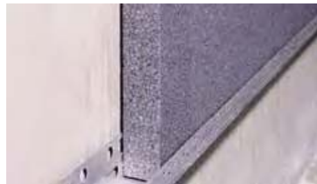
Установка теплоизоляционной плиты Kale EPS в посадочный профиль.
