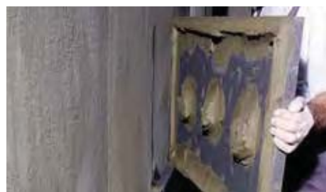
Затем, теплоизоляционную плитку, на заднюю часть которой нанесен штукатурный раствор, необходимо приклеить к стене.
