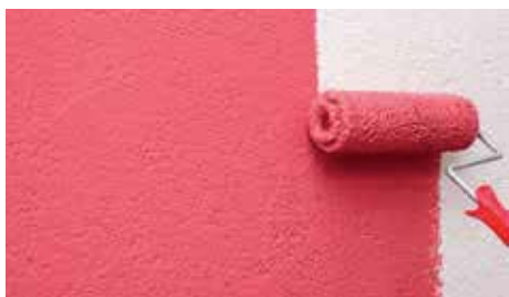
Нанесение фасадной краски Kale на Minart.
