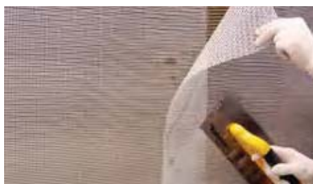
Армирующая сетка устанавливается так, чтобы стыки были усажены друг на друга на 10 см.
