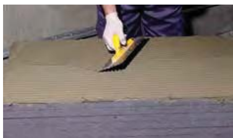
В зависимости от ровности поверхности необходимо пройтись скребковым шпателем (скребковый шпатель с зубцами 10x10 мм)
